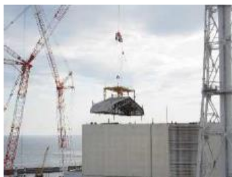
屋根パネル最後の一枚撤去
