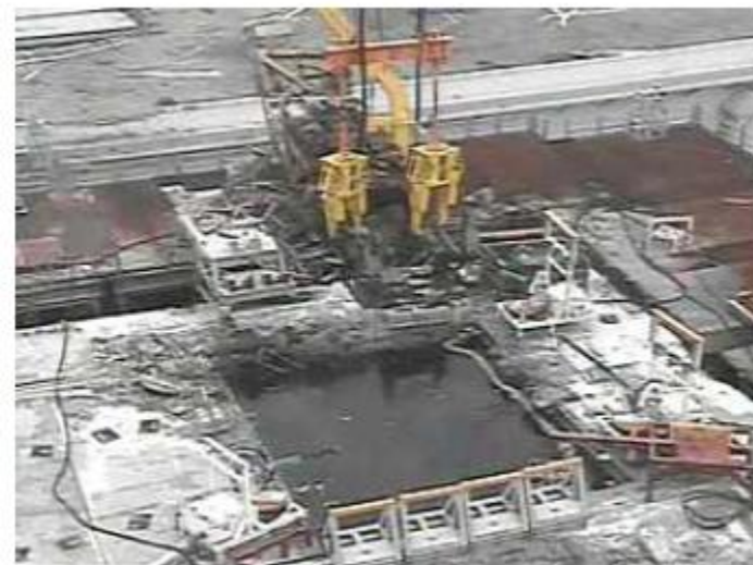
3号機SFプールから瓦礫取り出し
