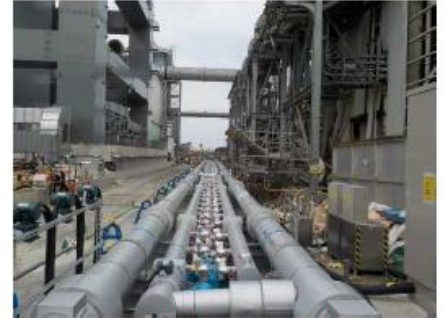
冷却配管設置状況
