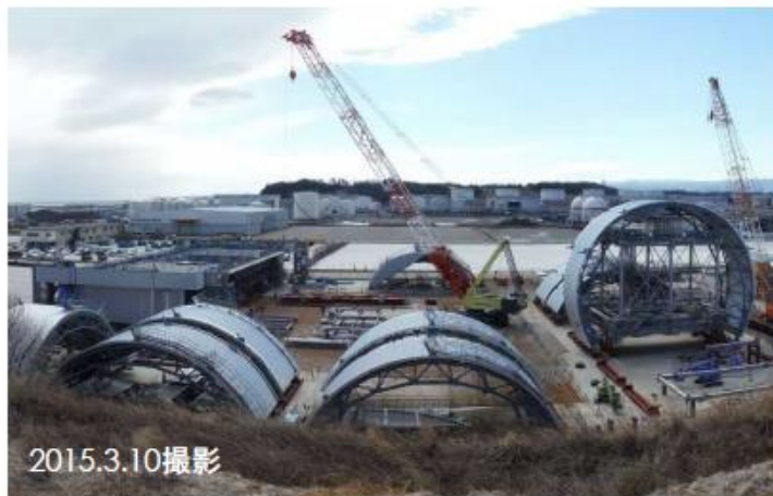
建屋カバー製作中
