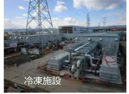
冷却配管設置状況
