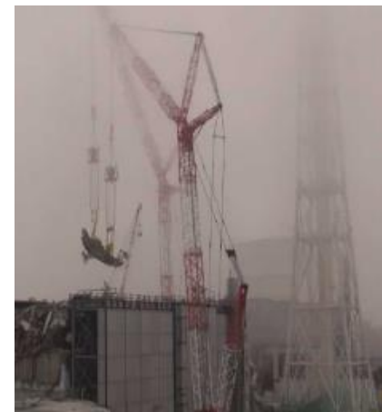
瓦礫撤去作業
