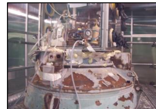
CIRCE - 放射性液体タンク
