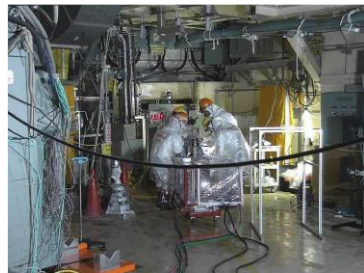
PCV外部 X6ペネ前作業エリア
