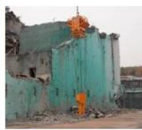
油圧ベンチ 散在がれきの撤去作業に 使用
