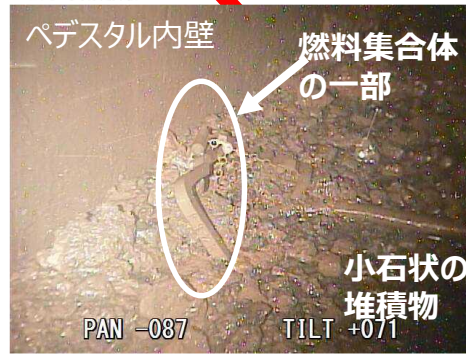
ペDESTAL内壁 燃料集合体の一部 小石状の堆積物 PAN -087 TILT +071 ペDESTAL底部
