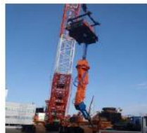
油圧カッター 屋根トラス、天クレの 切断に使用
