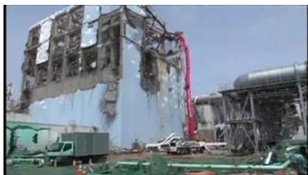
コンクリートポンプ車による使用済燃料への放水
