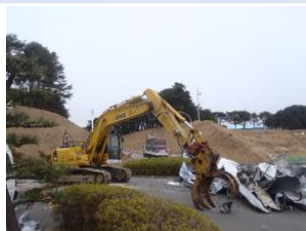
遠隔操作重機
