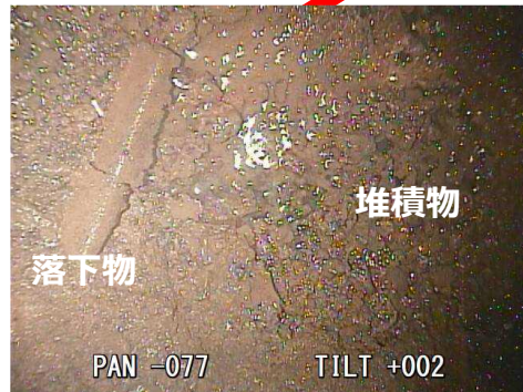
堆積物 落下物 PAN -077 TILT +002 ペDESTAL底部
