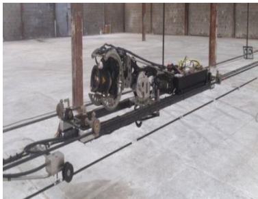
コンクリート構造内
