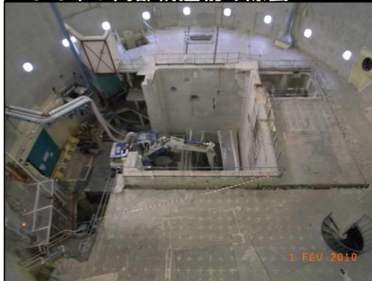
2010年：内部構造物の除去
