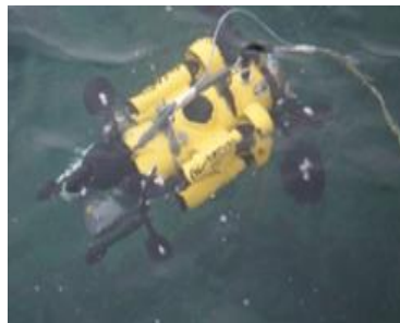
脱被覆プール内
