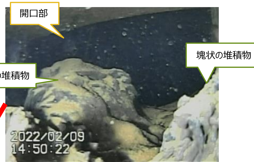
B. ペDESTAL開口部内部 塊状の堆積物
