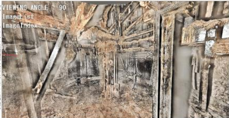
デブリとみられる堆積物が大量に付着した福島第一原発2号機の原子炉格納容器底部（東京電力提供）
