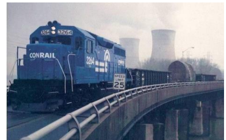
1986年から1990年 INLへの鉄道輸送キャスクによる49回の輸 送で、342キャニスター分の燃料とデブリ を運んだ
